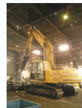
重機による回収
