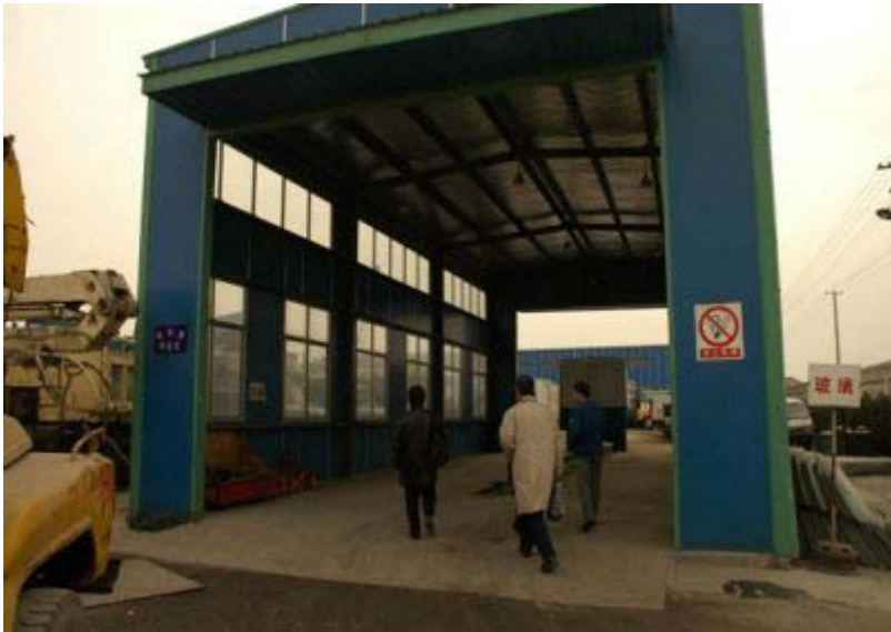
↑ オイルを抜き取るための作業場（建物の中に溝があり，車体の下からオイルを抜き取る）
